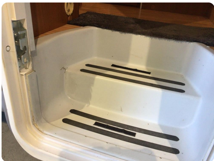
4.1 Sprekk Inngang må repareres.
