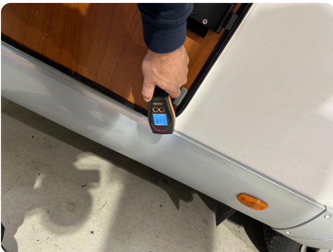
1 Målt fukt i % 75 Fukt i lasteromsluke.
