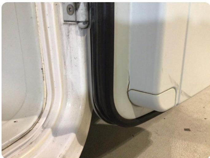
3.1 Skadet/merker etter utstyr Dørtrekk knekt.
