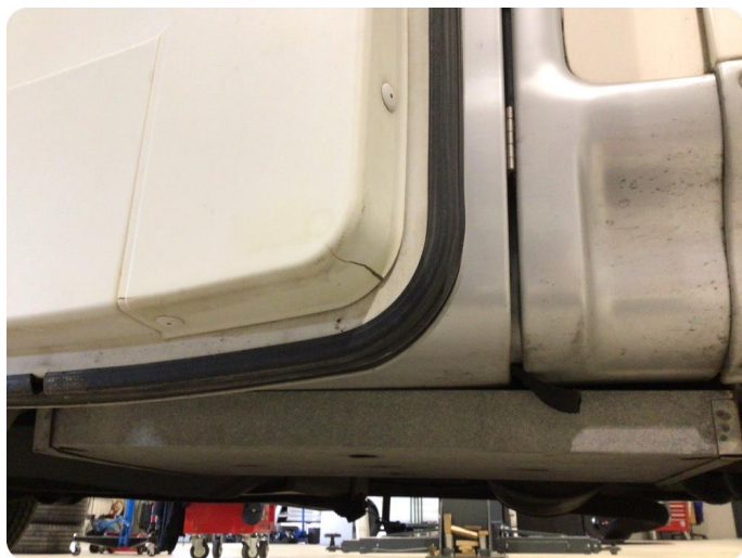
3.1 Skadet/merker etter utstyr Dørtrekk knekt.
